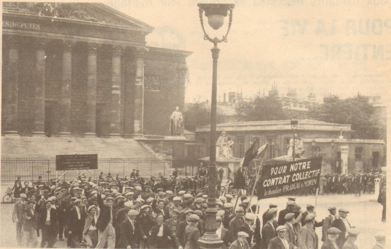
Défilé des grévistes du bâtiment devant la chambre des députés.
