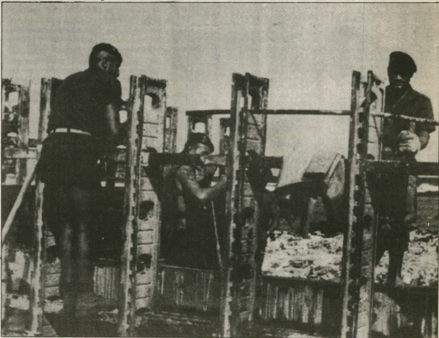
Des militaires construisant un barrage en béton armé sur l'atoll de Mururoa.
