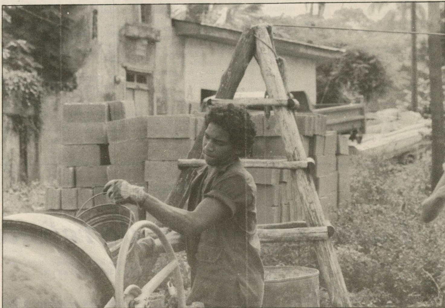
Chantier de bâtiment, à San Miguelito
