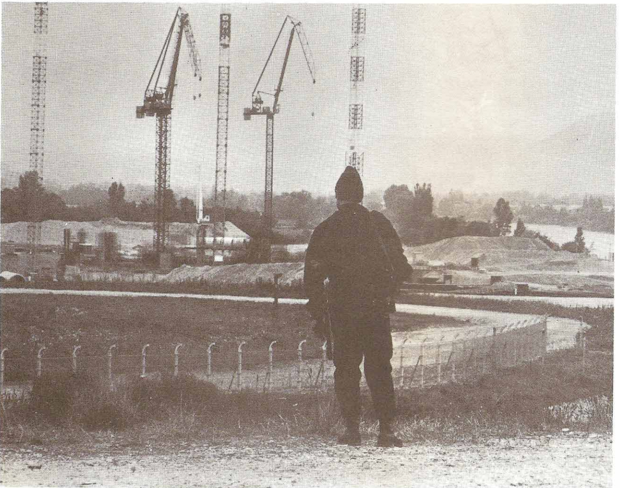
La construction de la centrale de Malville : un début pour la société policière du nucléaire .
